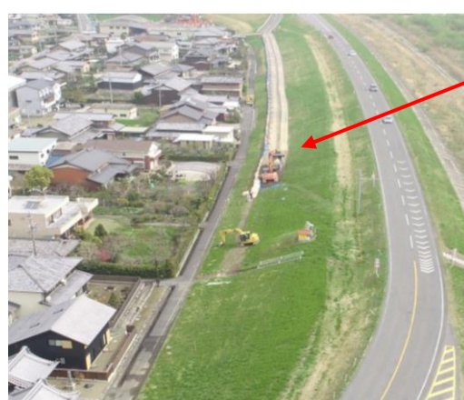
現在の進捗状況
