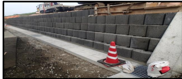
5月分施工完了 (起点箇所)
