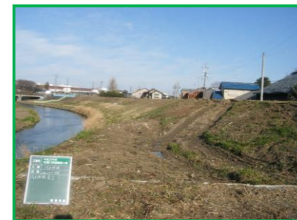
伐採作業完了
