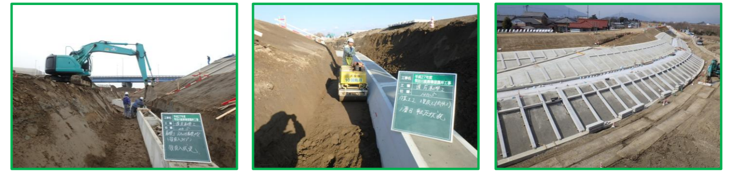
進捗率76%(2月末) 2月の作業風景(法覆護岸工) 基礎据付(ガウ投入)状況 基礎背面埋戻し状況 法枠据付状況
