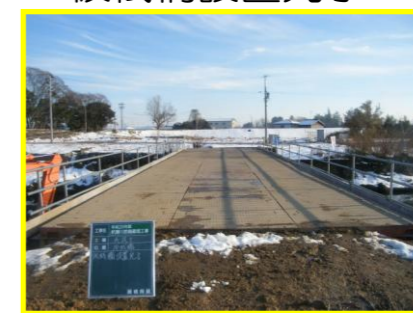
仮栈橋設置完了
